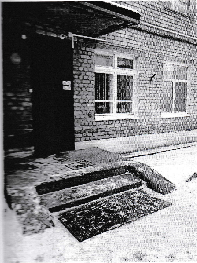
Фото 2 «Входы в здание»
